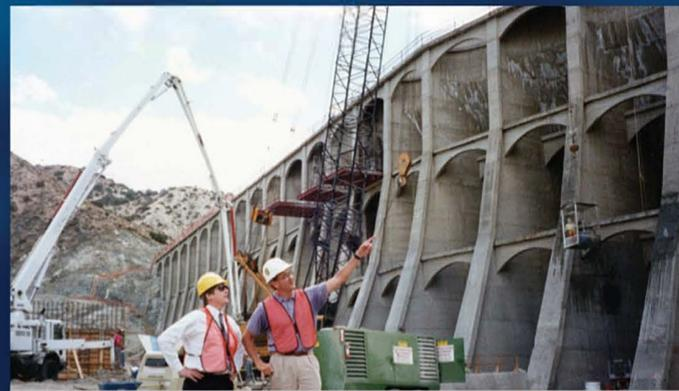
*La fachada original de la presa Littlerock se cubrió con un gran contrafuerte de hormigón compactado con rodillo en la década de 1990.*
