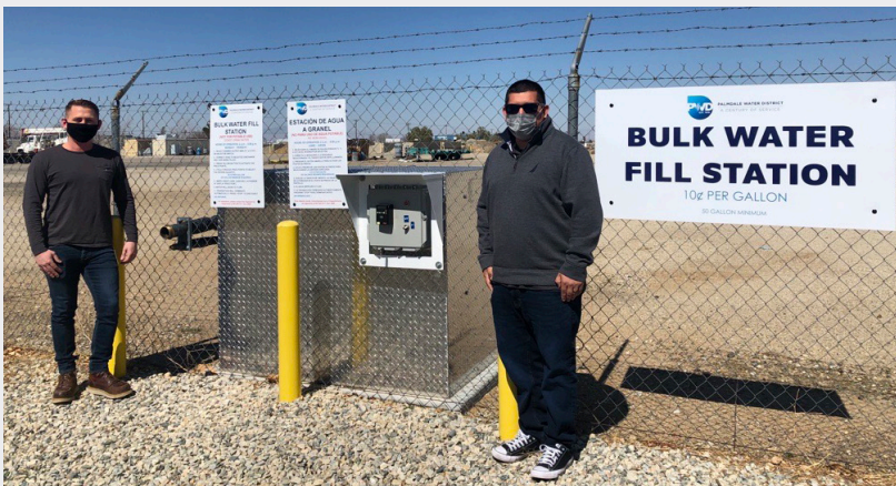
El ingeniero asistente Jaron Hollida (izquierda) y el técnico de ingeniería Daniel Maldonado (derecha) revisan la estación de llenado de agua a granel.
