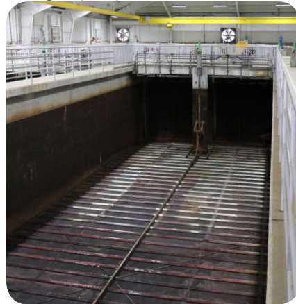
Una de las cuencas de sedimentación se drena para su limpieza e inspección.
