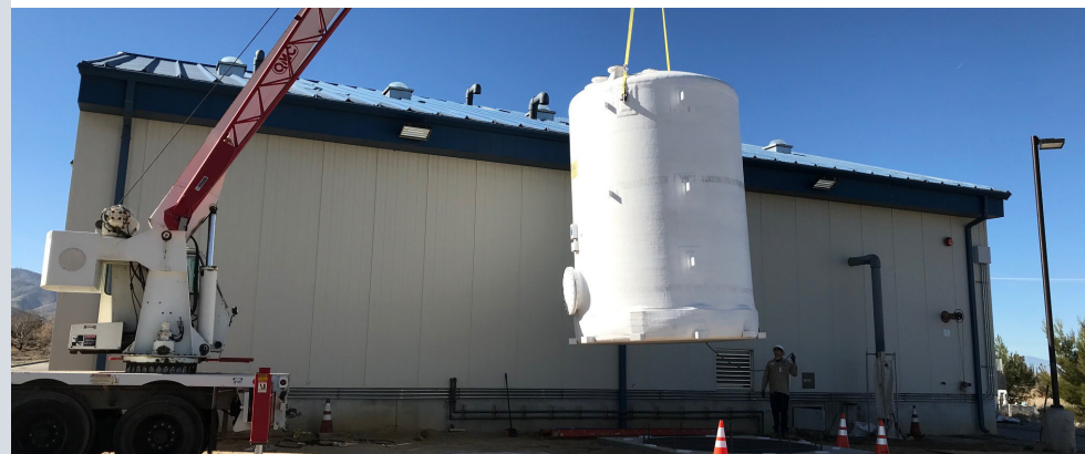
El nuevo tanque de salmuera de agua salada se instala en la planta de tratamiento.
